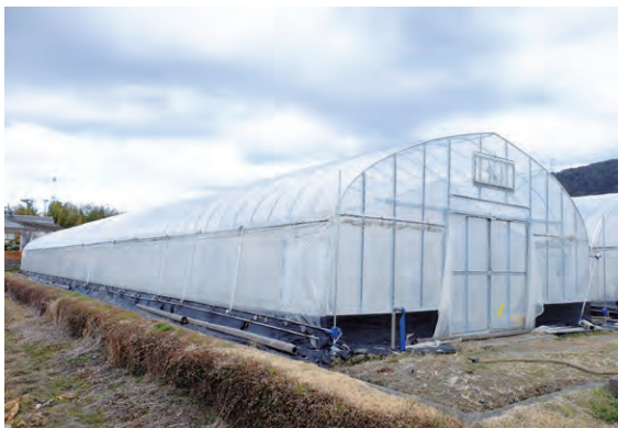
リース事業を活用して建設されたハウス
